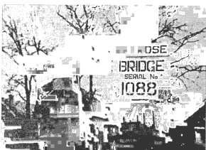
Bij de brug naar De Maten werd een noodbrug gelegd. (Bailly-bridge) Op de achtergrond de winkel van Bonkes. De brug is genoemd naar het Schotse dorpje Melrose. (1088= brug code; 41= code van genie regiment; 40= aantal tonnen)
